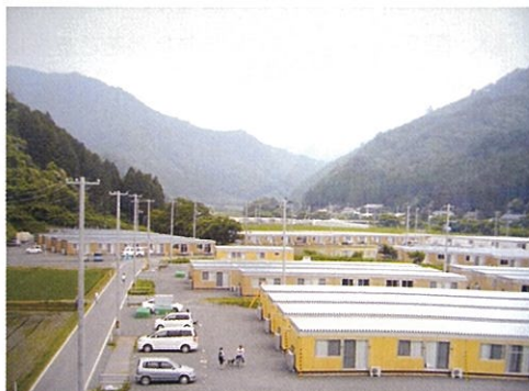
岩手県大槌町・大和ハウス工業株式会社のプレハブ住宅（2011年6月撮影）
